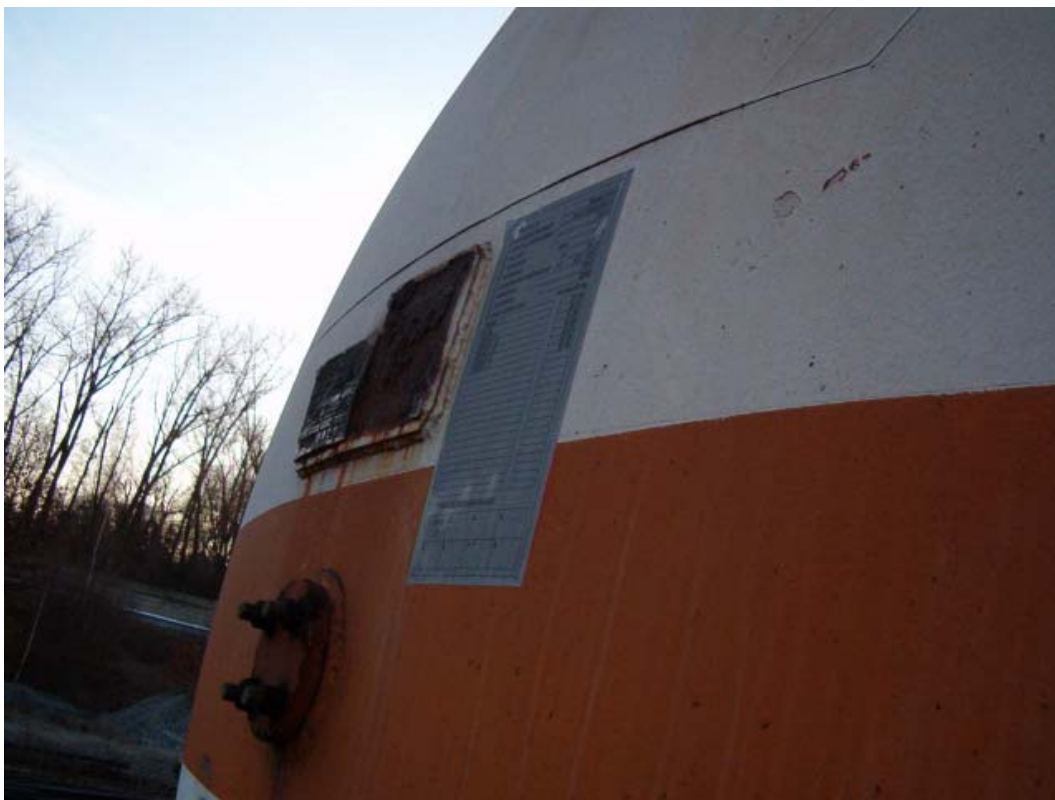
chybné provedení štítku – papírová samolepka
